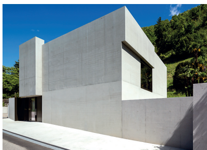
Il nuovo deposito d'arte con sala espositiva di «Ronco dei Fiori».
